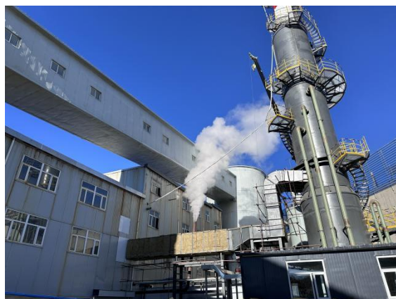
废气处理设施-脱硫设施
