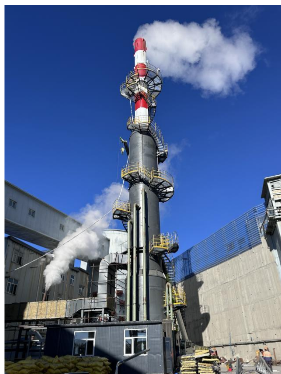
废气处理设施-脱硫设施
