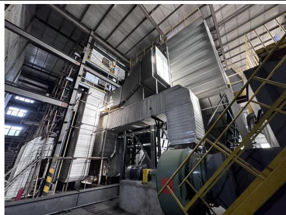
废气处理设施-除尘、脱硝设施
